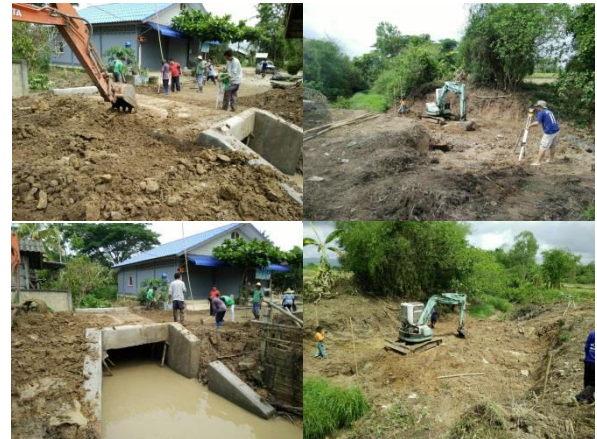
กองช่าง องค์การบริหารส่วนตำบลแม่ฮ้อ ตรวจสอบสร้างฝาย คสล. หมู่ที่ 14 บ้านแม่แก้วรุ่งเรือง หมู่ที่ 6 บ้านแม่แก้วกลางและก่อสร้างท่อเหลี่ยม หมู่ที่ 17 บ้านแม่แก้ว
